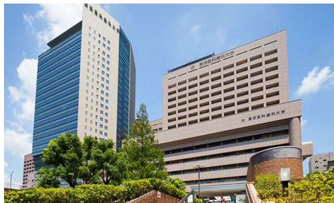
右が医科系病院、左が大学の研究棟である M&D タワー
